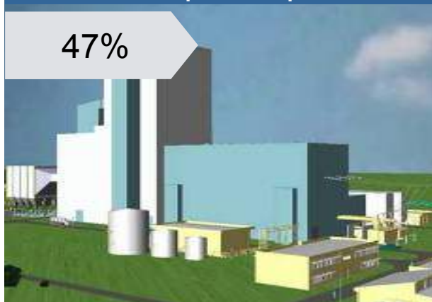
Reference STPP NRW, 600 MW
